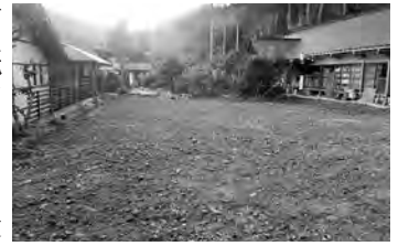
解体工事の済んだ講堂建設予定地
