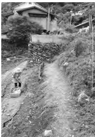
定福寺第三駐車場周辺整備
